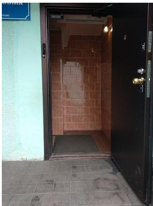
Фото 13 Дверь входная (вид снаружи)/дверь открытая
