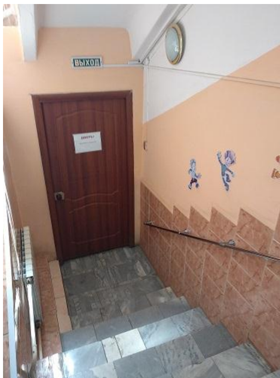
Фото 14 Дверь входная (вид внутри здания)
