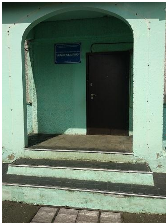
Фото 12 Лестница (наружная)/ Входная площадка перед дверью
